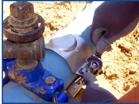
Serrer avec une clé de 19, jusqu'au contact inférieur de la bride avec la partie cintrée du collier
