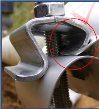
Sur semi-rigides : serrer en butée des 2 côtés et rajouter au maximum 3 coups de clé supplémentaires (équivalent à 1.5 tour de l'écrou)
