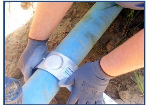
Poser le collier côté joint sur la canalisation et appuyer de chaque côté pour le préformer
