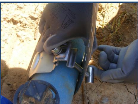
Approcher les deux parties du collier en les pinçant jusqu'au contact et visser manuellement le lopin le plus loin possible
